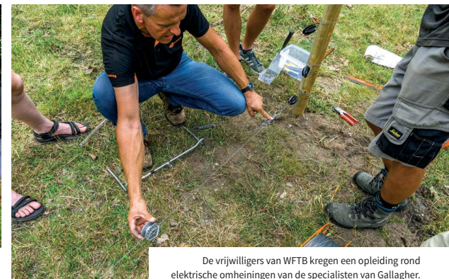
Zwakke en te korte hoekpalen worden vervangen door stevig verankerde palen.
