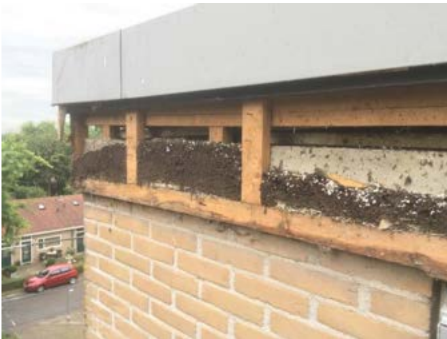
Figuur 4. Ophoping van vleermuisuitwerpselen achter boeiboorden. Waar vleermuizen regelmatig komen laten ze vrijwel altijd duidelijke sporen na. Door naar zulke sporen te zoeken kijk je als het ware terug in de tijd. Foto Wim van den Heuvel.*
