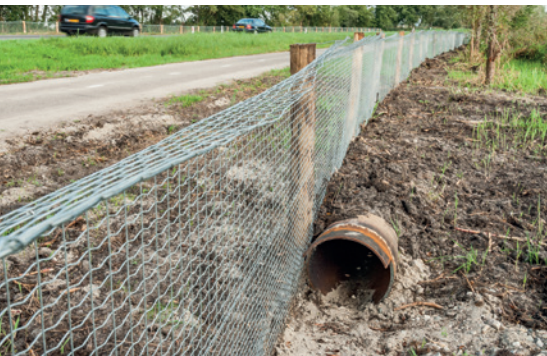
▲ Otterpassage onder Veneweg. Foto Roel Hoeve
