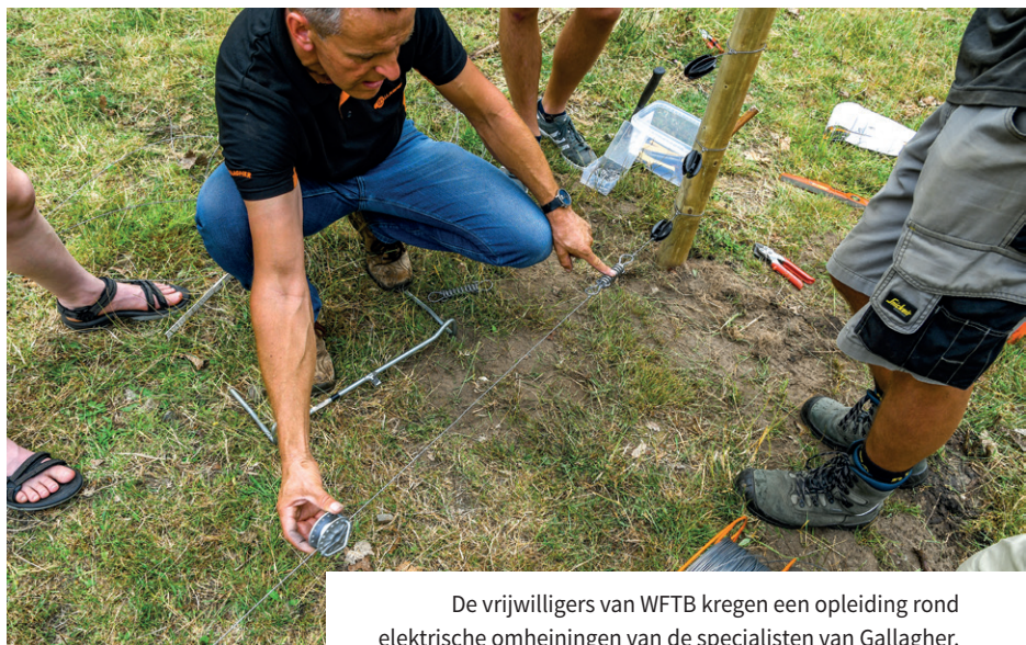
Zwakke en te korte hoekpalen worden vervangen door stevig verankerde palen.
